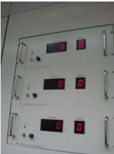
写真-2.2.1：防災センターに設置された震度表示モニタ
