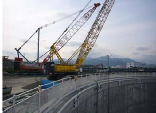
写真 2：貯槽内に資材を供給する大型クレーン
