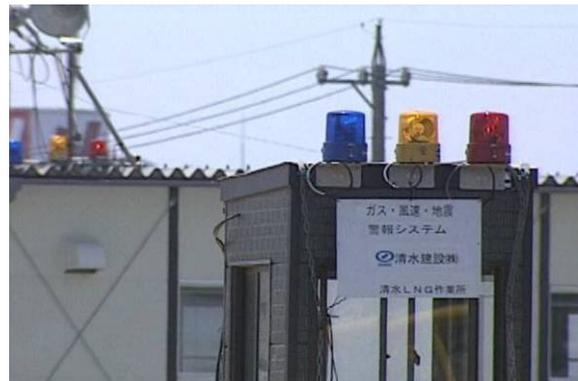
写真 3：屋外に設置されたガス・風速・地震の警告灯
